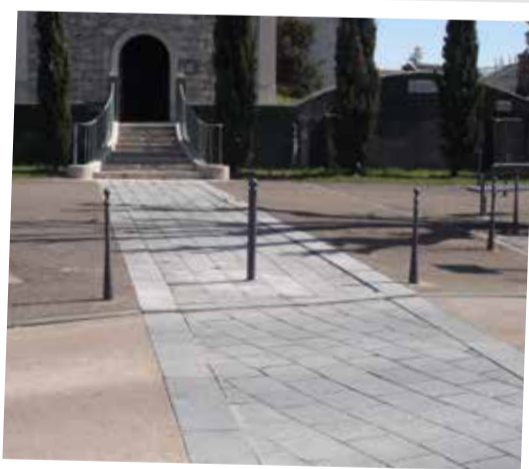
Mise en place de potelets de sécurité
