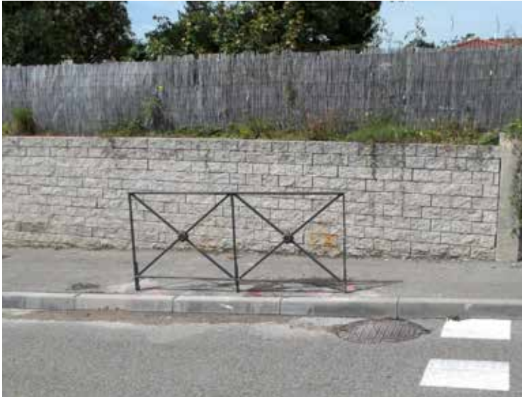
● Installation d'une barrière de protection piétons rue Messimy
